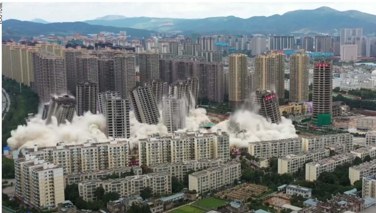
À Kunming, dans la province du Yunnan, en 2021, les autorités ont démoli 15 gratte-ciel inachevés depuis plusieurs années et devenus inutilisables.
