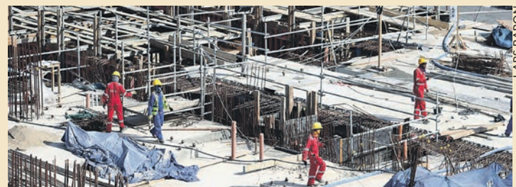
Sur un des chantiers du Mondial 2022 au Qatar.
