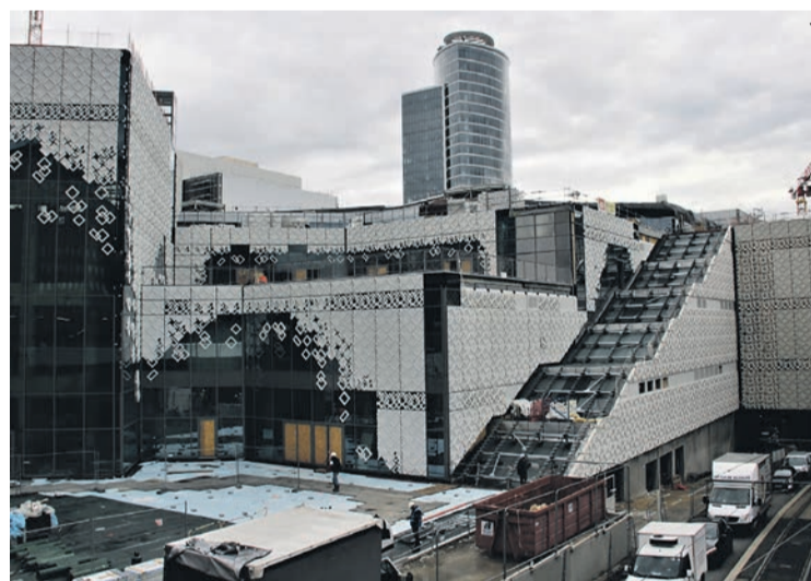
Le chantier du centre commercial de la Part-Dieu.
