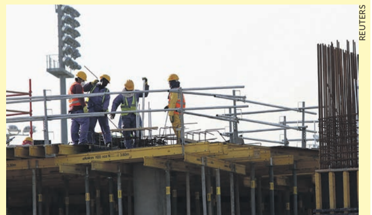
Sur un chantier de la Coupe du monde au Qatar.
