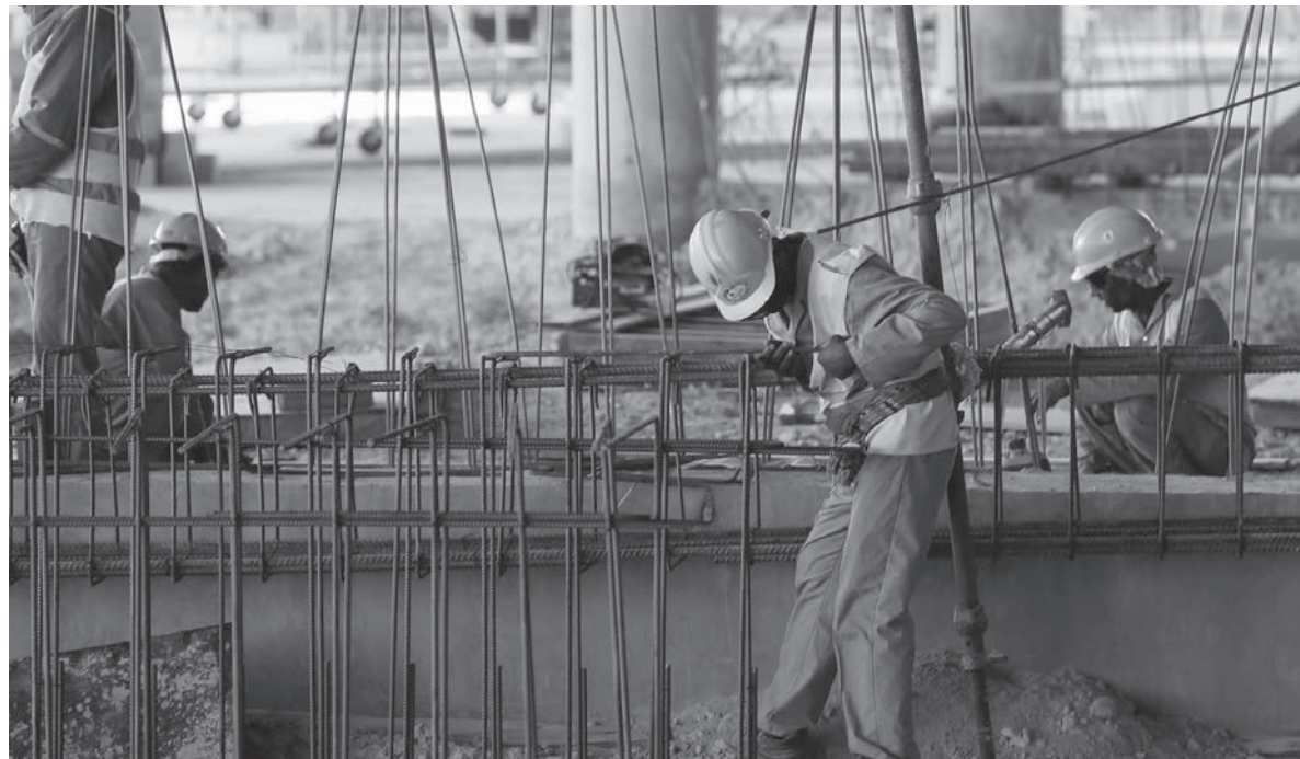
Sur un chantier du Qatar.
