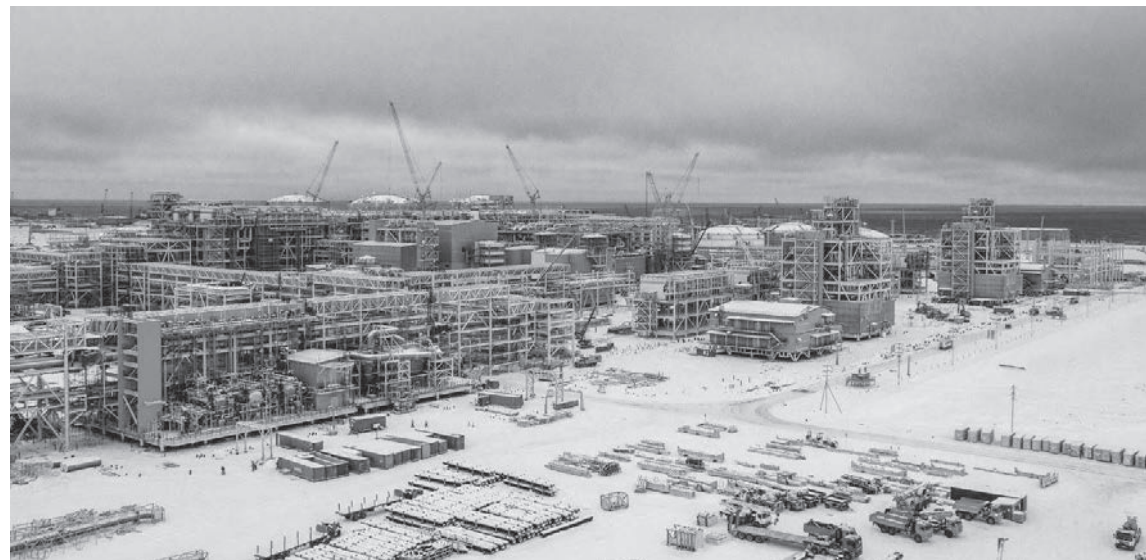
L'usine de liquéfaction de gaz en construction.
