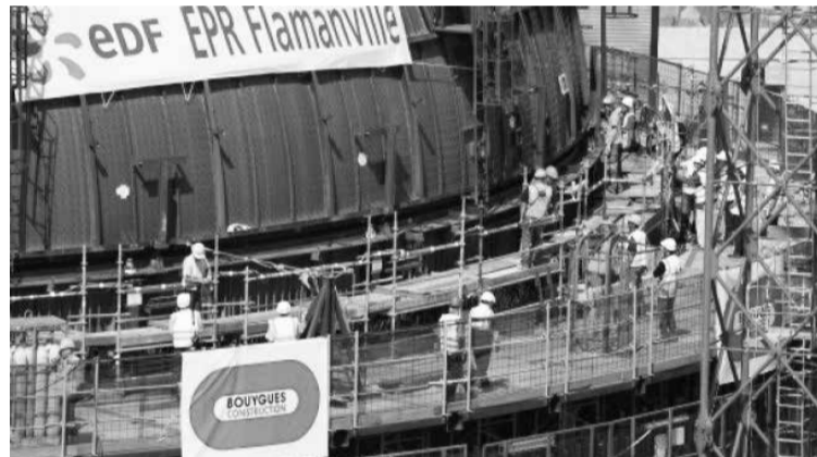
Le chantier de l'EPR à Flamanville, à l'enseigne de Bouygues.
